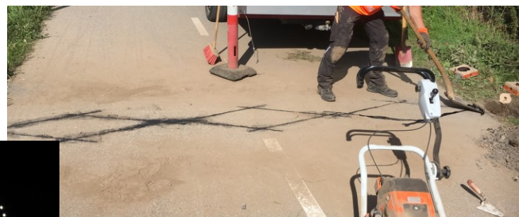
Skæring af spoler til afgivelse af signal til tænd/sluk funktionen.
